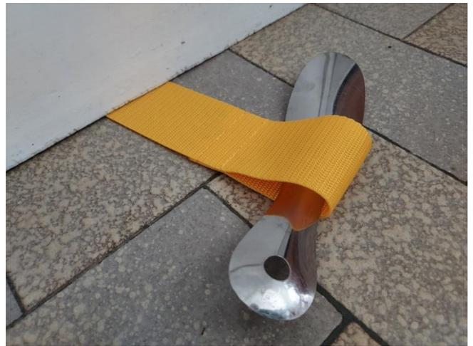
Sangle solidaire du Paréau et retenue par une boucle verrouillée passant sous la porte.
