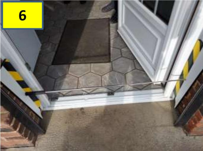
Mise en position et blocage de fausses feuillures fines (cas de pente de seuil élevée)
